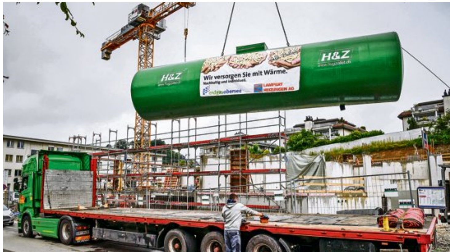
Ein Lastwagen transportierte den Tank an die Tägernastrasse. Ein Kran hievte die schwere Last dann in den Keller des Neubaus. zvg / Erdgas Obersee
